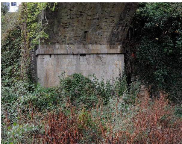
Figura 5: Vista delle spalla
