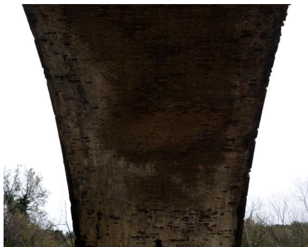
Figura 6: Vista intradosso arco
